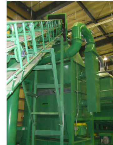
冷却機 製造されたばかりの熱を持った RPF を外気温程度にまで冷却します。
